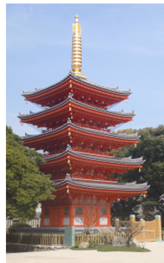
制震システムを導入した新築の 東長寺五重塔
